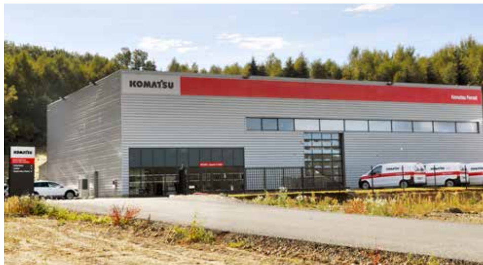
La nouvelle unité de maintenance à Egletons a été inaugurée en automne.
